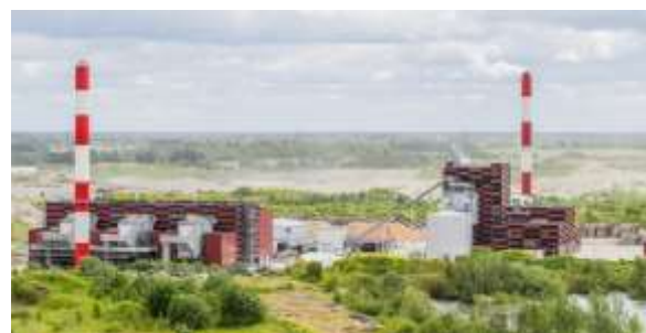
Figure 15 - Tallinna Elektriijaam power plant (Source: OÜ Utilitas Tallinna Elektriijaam)
