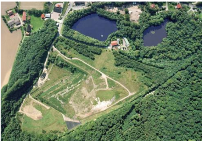
Landfill Doerentrup Aeration
