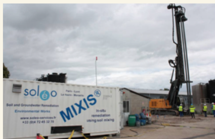
Traitement d'un sol contaminé aux solvants chlorés par injection de nanoparticules de fer zérovalent. Soléo Services
