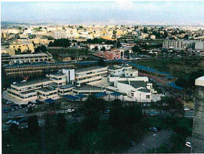
Figura 1. Impianto PV dell'ospedale Brotzu di Cagliari
