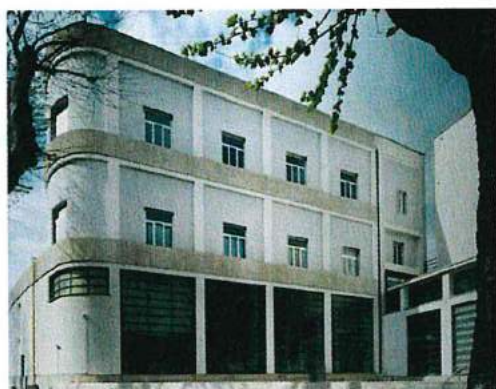
Figura 7. Pre-interventi Edificio B
