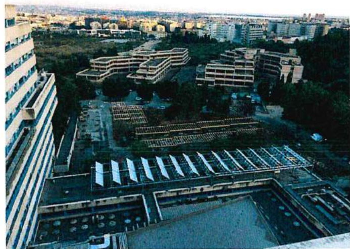
Figura 2. Impianto solare termico dell'ospedale Brotzu di Cagliari
