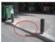
Inappropriate Ramp Ακατάλληλη Ράμπα
